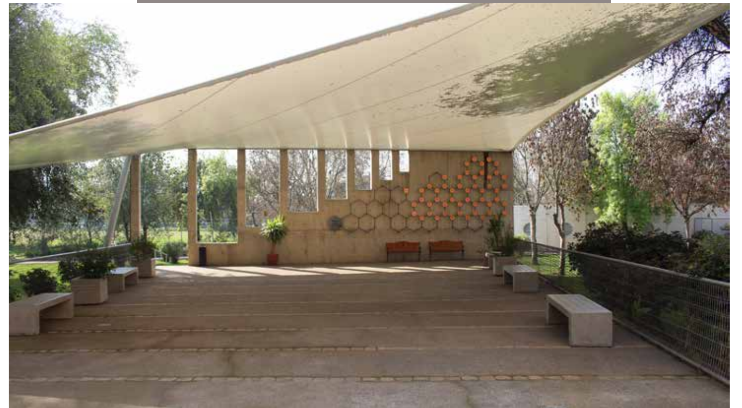
Abajo, en 2016 se instaló la tensoestructura del "Paseo de la Ciencia".
